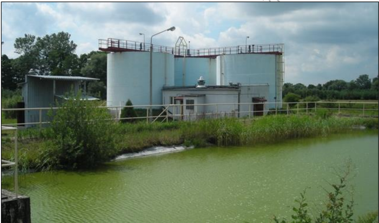
Fot. 17. Oczyszczalnia ścieków we wsi Wartkowie, w dolinie Neru
