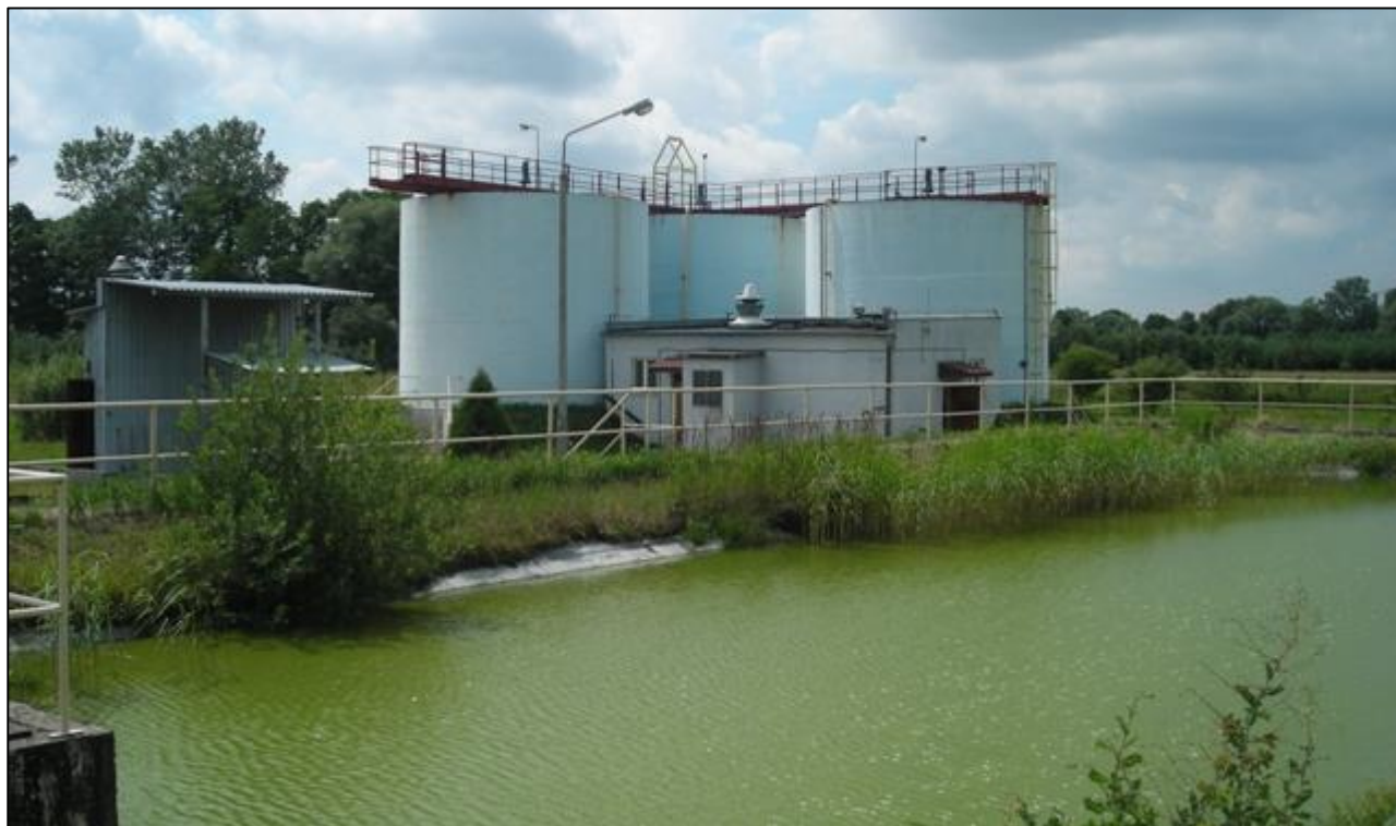
Fot. 17. Oczyszczalnia ścieków we wsi Wartkowiec, w dolinie rzeki Ner
