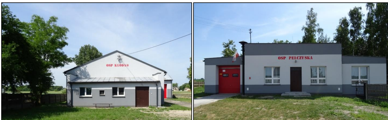
Fot. 16. Budynek OSP Kłodno i OSP Pełczyska
